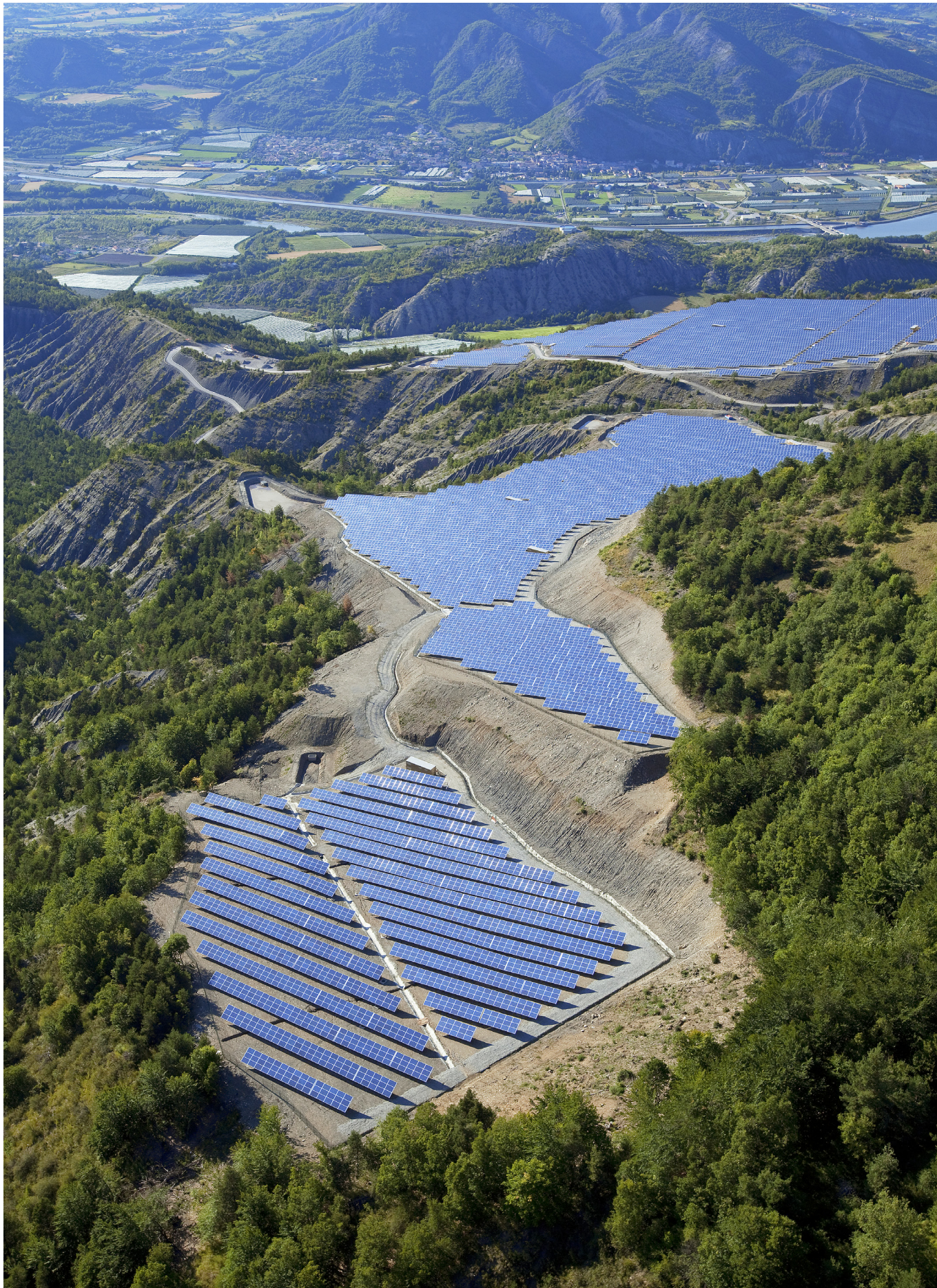
La centrale solaire de Curbans compte 105 000 panneaux photovoltaïques. Alpes-de-Haute-Provence
